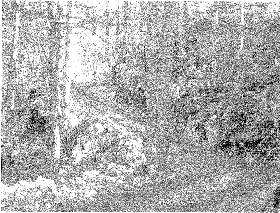
Fotos 10: Šumski kamionski put probijen u živoj krečnjačkoj stijeni na planini Bjelasici u 2009. godini, Š.G. «Botin» Nevesinje (foto: Agencija za šume)
